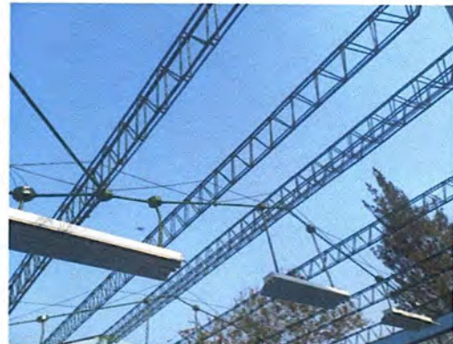
Foto 4: Mejoramiento de la estructura del techo
