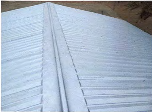
Foto 1: Capotes y láminas colocadas
