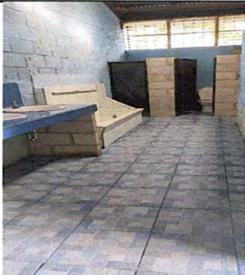
Foto 1: Mejoramiento de Módulo de Sanitario de Niños
