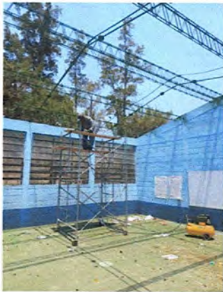
Foto 3: Mejoramiento de estructura de techo
