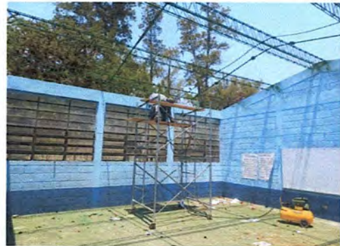
Foto 2: Reforzamiento de Estructura de techo
