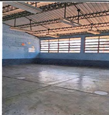
Foto 2: Pernos y remaches colocados segundo grado
