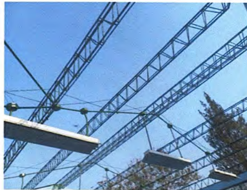
Foto 4: Mejoramiento de la estructura del techo
