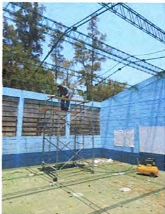
Foto 3: Mejoramiento de estructura de techo
