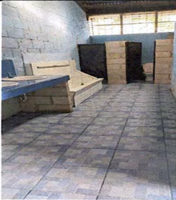
Foto 1: Mejoramiento de Módulo de Sanitario de Niños
