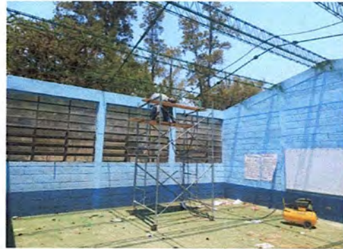
Foto 2: Reforzamiento de Estructura de techo
